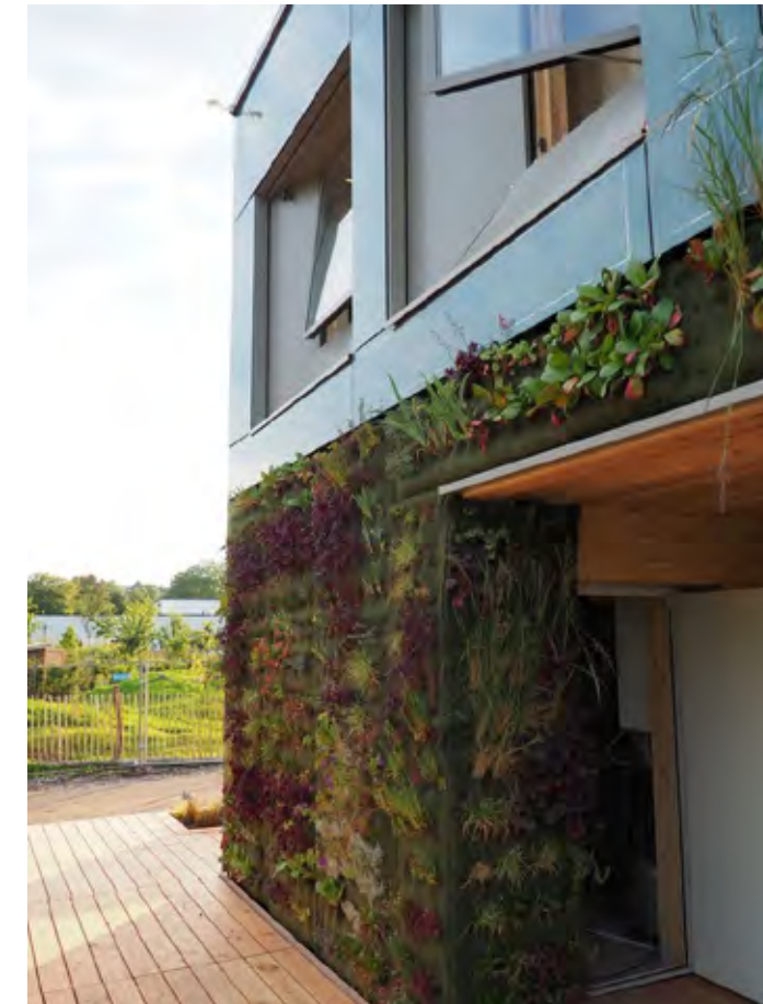
Abb. 102 SolarDecathlon 21/22 Eingabe von Local+. Bei der Fassadengestaltung wurden PV und begrünte Flächen klar voneinander getrennt (© team-localplus)
