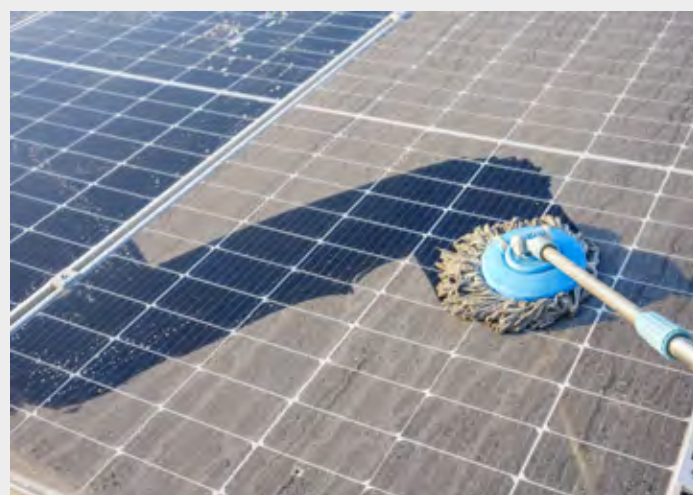
Abb. 7 Verschmutzungen können den Stromertrag mindern, eine regelmässige Reinigung ist empfehlenswert © AdobeStock
