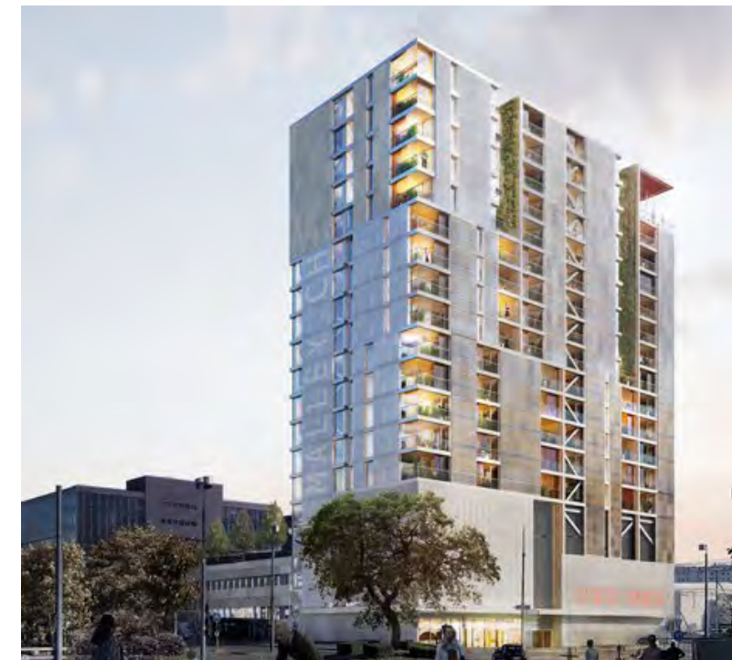
Abb. 67 Auch bei über 30m hohen Gebäuden können PV-Fassaden angewendet werden. Objektspezifische Lösungen sind in Zusammenarbeit mit Fachexperten zu entwickeln. (© Malley Phare CCHE, Prilly/Lausanne)
