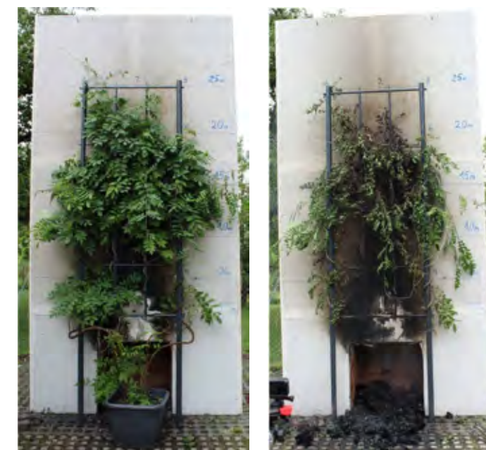
Abb. 62 Brandversuch mit einem troggebundenem System. Pflanzenart: Blauregen. (© NODER „Begrünte Fassaden aus brandschutztechnischer Sicht“, 2019).
