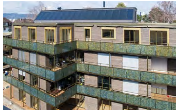
Abb. 91 Mehrfamilienhaus in Altstetten, PV-Elemente an den Balkonen bieten Privatheit und schaffen gleichzeitig eine horizontale Gliederung der Fassade (© Kämpfen Zinke + Partner AG)
