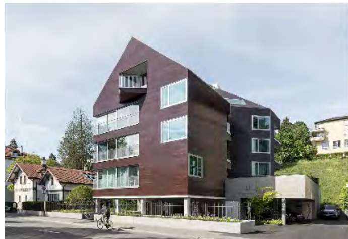
Abb. 99 Wohngebäude in Zürich, Solaris 416, opake PV-Fassade und Dach, einheitliche Farbwahl der verwendeten Module (© Beat Bühler)
