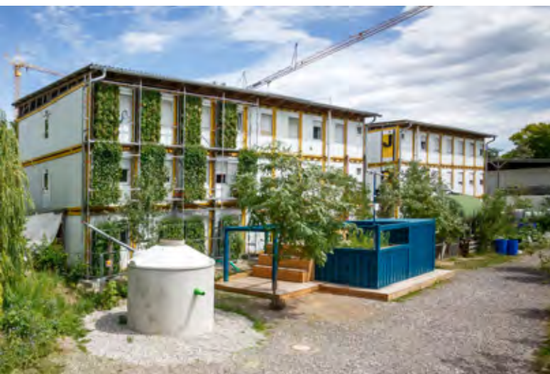
Abb. 84 Rosensteinviertel in Stuttgart, Versorgung der Fassadenbegrünung mittels Regen- und Duschwasser (© J. Rettig).
