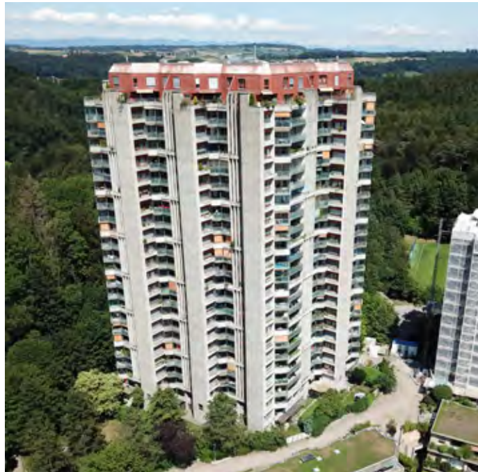
Abb. 114 Hochhaus Holenackerstrasse 65 in Bern (© Elektroplanung Schneider AG)
