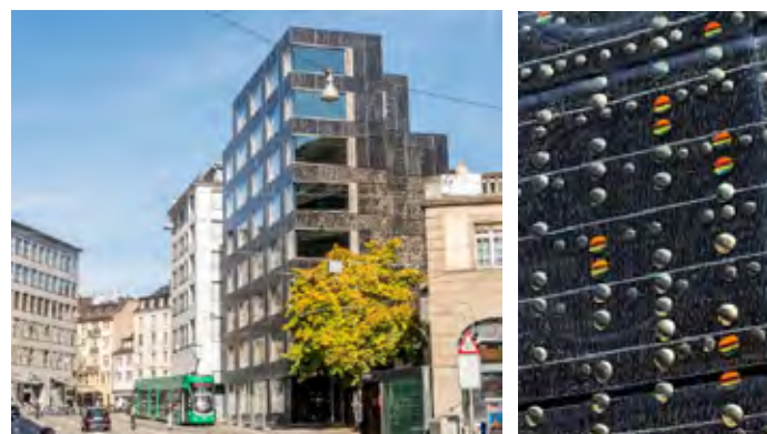
Abb. 101 Amt für Umwelt und Energie in Basel, individuell gestaltete PV-Paneele geben dem Gebäude seinen Ausdruck (© AUE)
