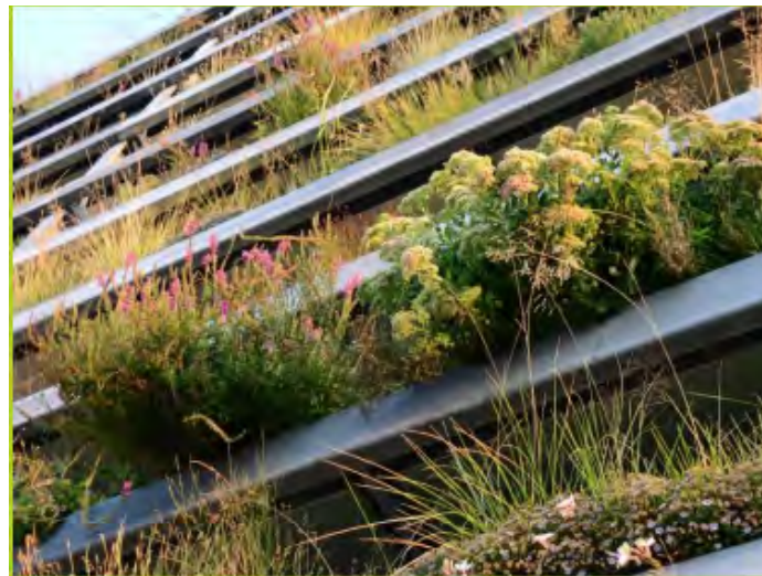
Abb. 110 Zweimal im Jahr ist ein Pflegedurchgang der Fassadenbegrünung notwendig (© Roger Ingold)
