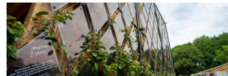
Abb. 104 SolarDecathlon 21/22 Eingabe von CoLLab, das Rankgerüst an der Fassade wird sowohl für PV-Module als auch Begrünung genutzt (© Lukas Fischer, HFT Stuttgart)
