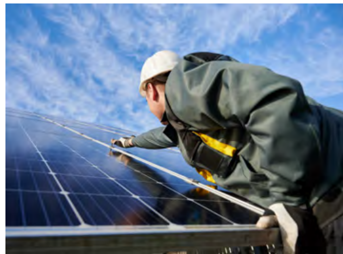
Abb. 86 Eine gute Demontierbarkeit der einzelnen Module erleichtert den Ersatz von defekten PV-Elementen.
