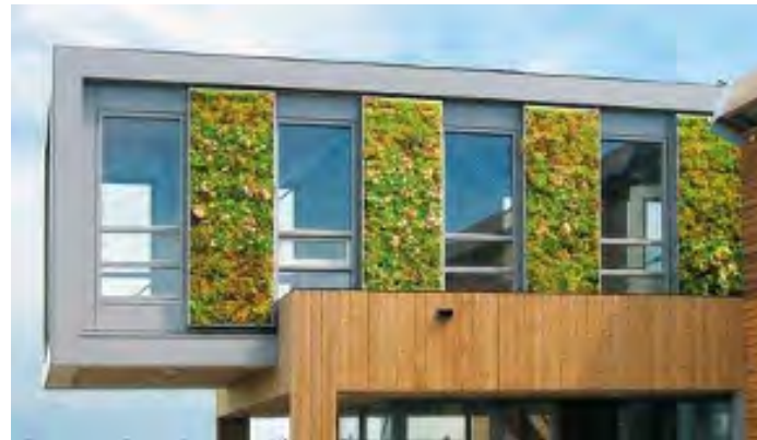
Abb. 81 Wandgebundene Begrünung sind regelmässig zu pflegen, dadurch kann ein Überwachsen der Module verhindert werden (©baulinks.de)
