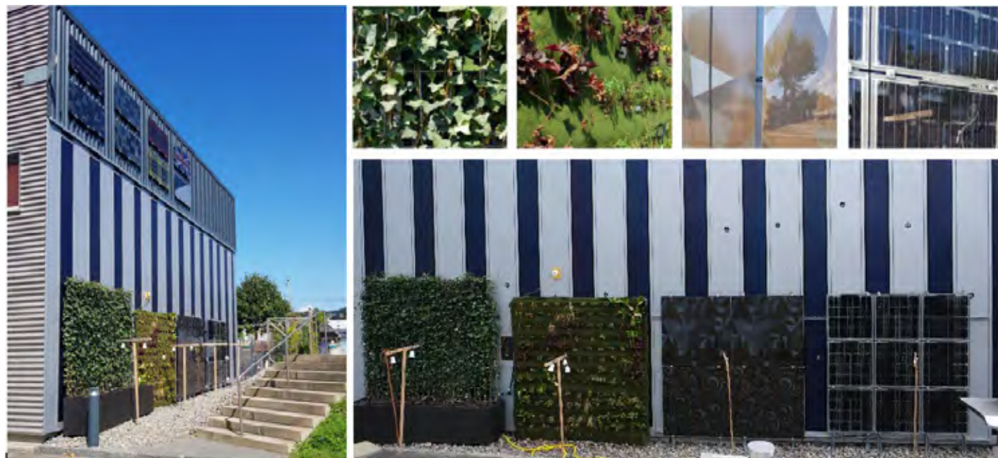
Abb. 42 Fassadenprüfstand auf dem Campus der HSLU in Horw
