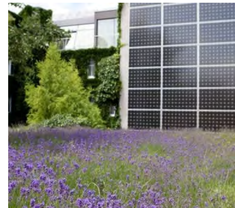
Abb. 59 Die Kombination von PV und Begrünung lohnt sich im Hinblick auf viele Aspekte (© Boutiquehotel Stadthalle Wien)
