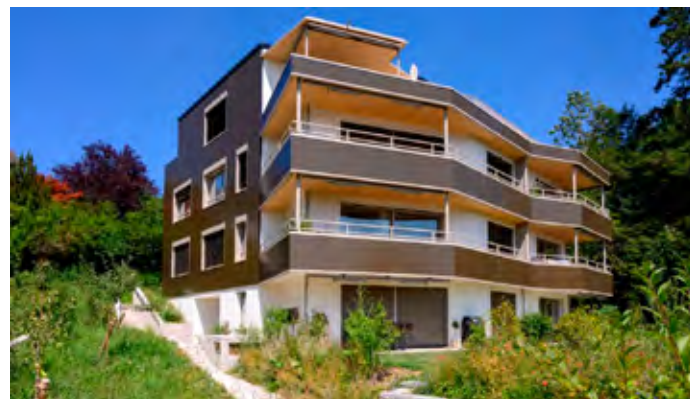
Abb. 100 Wohngebäude in Zürich, Höngg, opake PV-Module gestalten die Fassade des Wohngebäudes (© Kämpfen Zinke + Partner AG)
