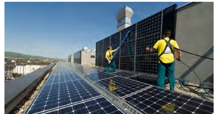
Abb. 76 Pflege- und Instandhaltungsarbeiten bei begrünten (oben) und PV-Fassaden (unten, © Hägni AG).
